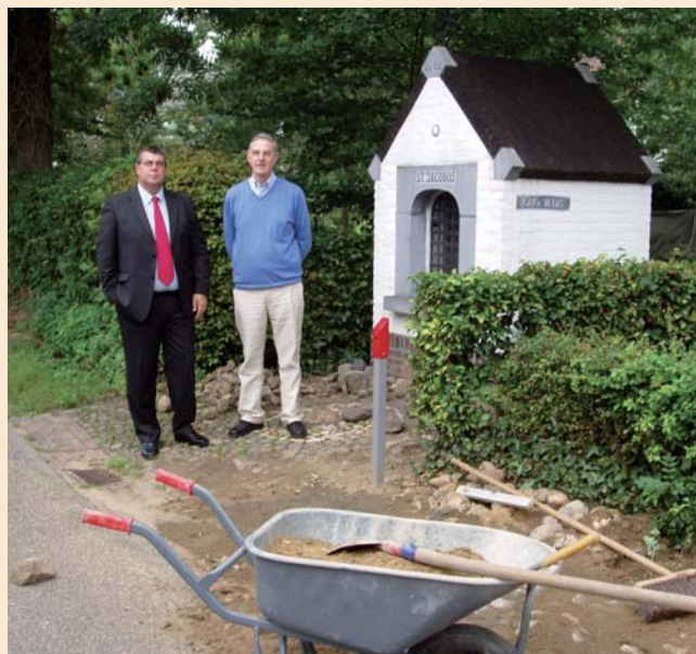
Wethouder Johan Lalieu bekijkt de stand van de werkzaamheden aan de Jacobuskapel. Rechts de eigenaar van de kapel.
