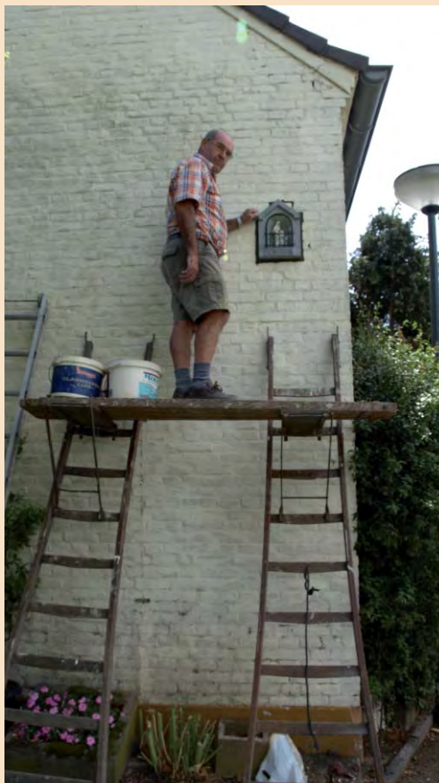
Wiel Smeets bezig met het plaatsen van de muurnis.
