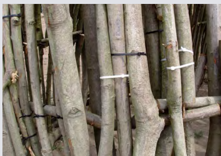
Een slimme manier om de staken te verbinden
