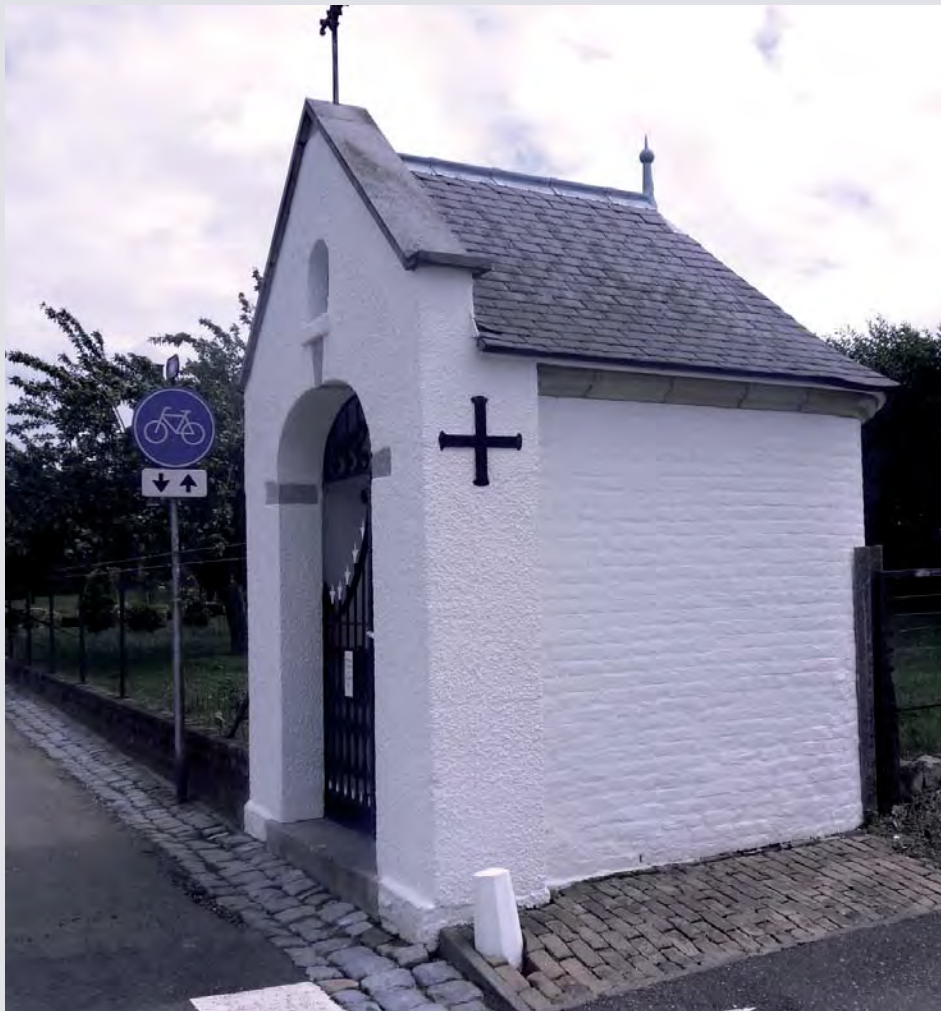
De kapel Raar in Meerssen valt onder de aanvragers van 2011. Het aanbrengen van drainage langs de gevels moet schade door optrekkend vocht voorkomen. Dit werk zal in 2012 worden uitgevoerd.
