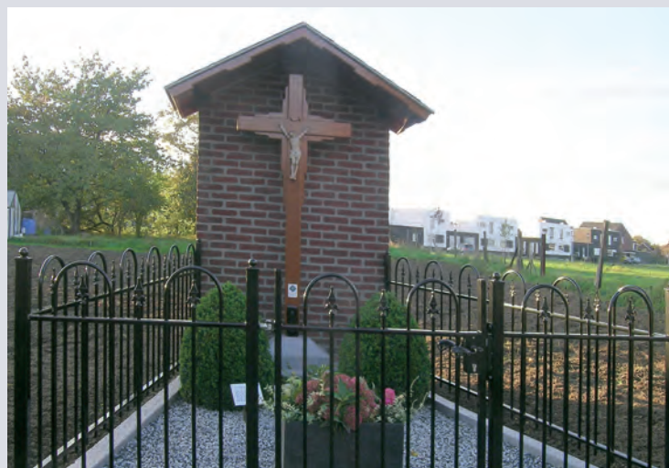
Kruis na de renovatie
