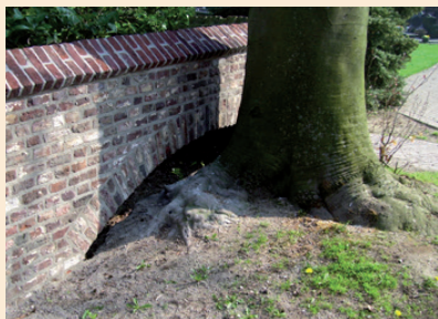
Oplossing op advies Monumentenwacht Limburg om middels boogconstructie boom te sparen
