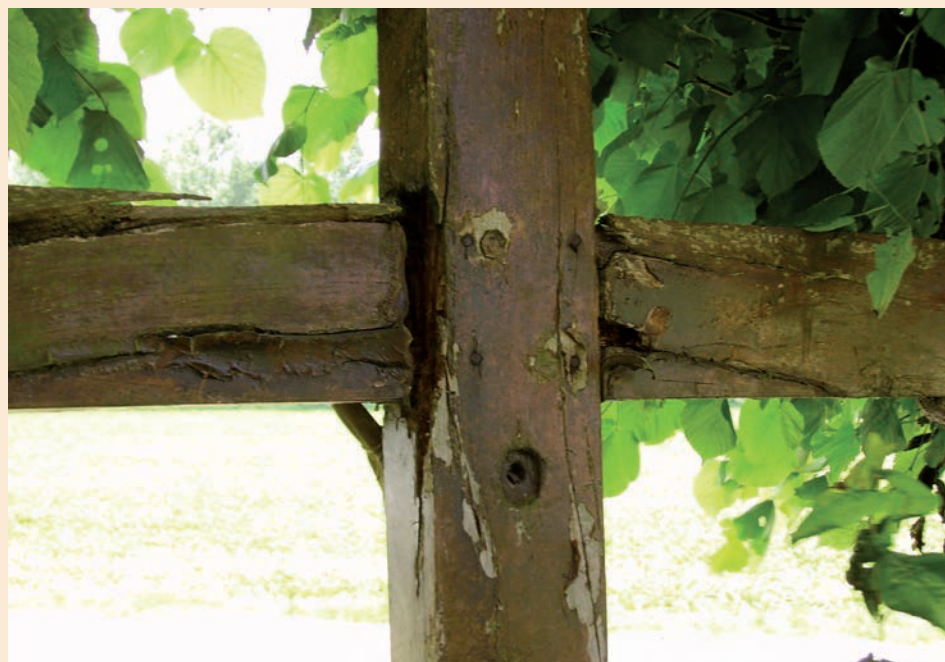
Aantasting van een houtverbinding
