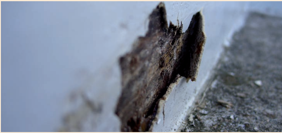
Loskomende pleisterlaag
