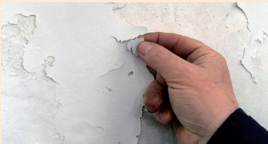
Loskomende afwerklaag
