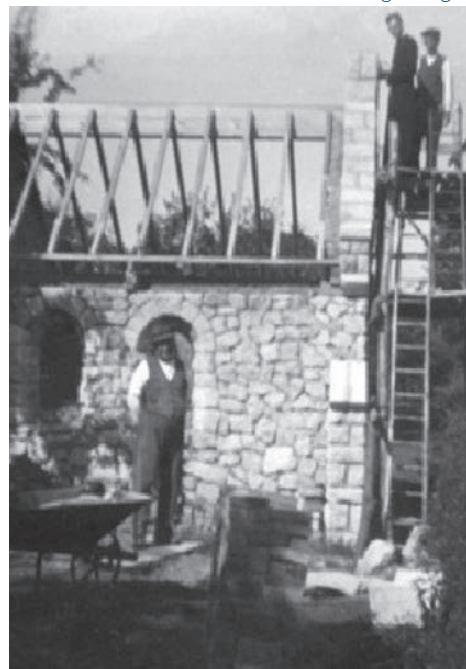
De bouw vordert gestaag ...
