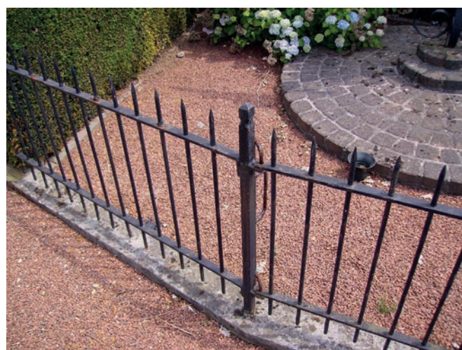
Roestvorming hekwerk
